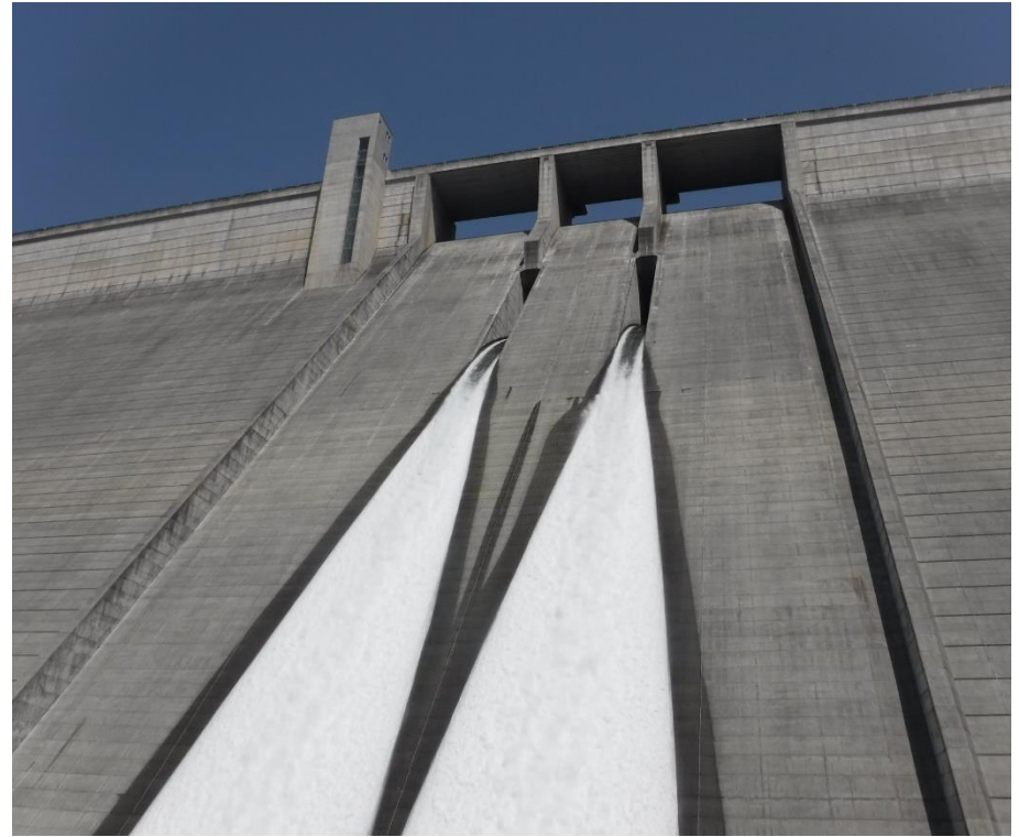
長井ダム・雪解け水の越流
