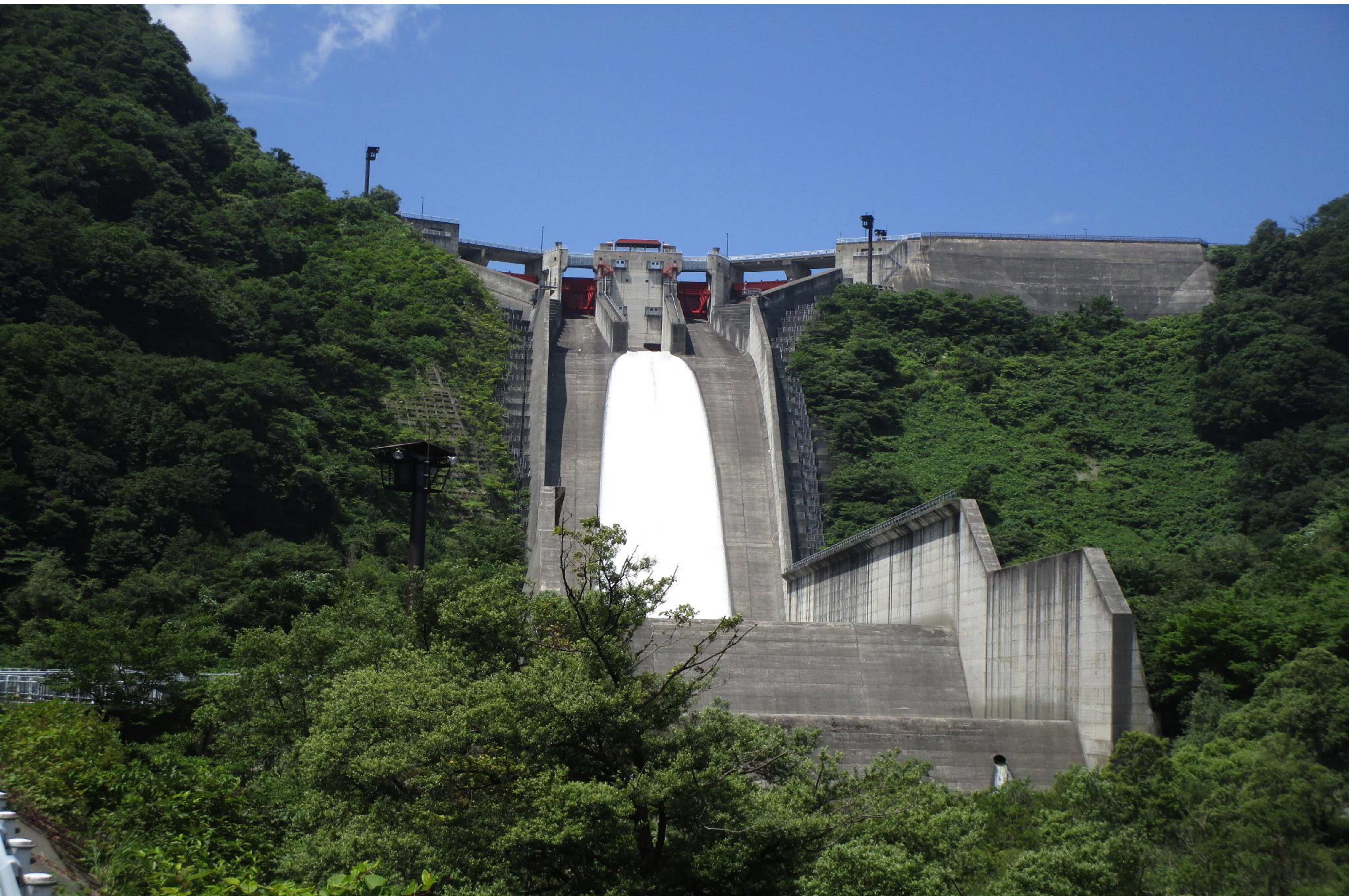
寒河江ダム オリフィスゲートからのフラッシュ放流
