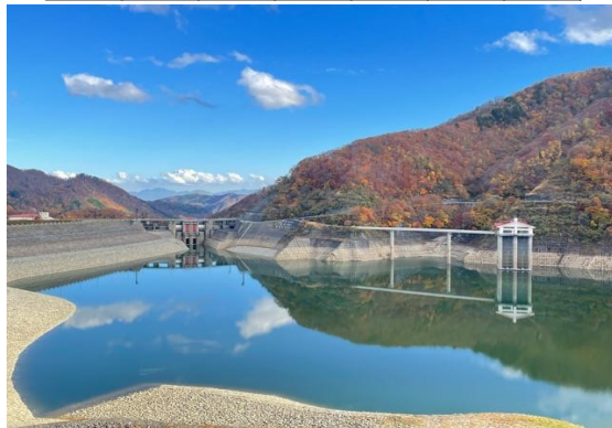
11月 November 寒河江ダム
