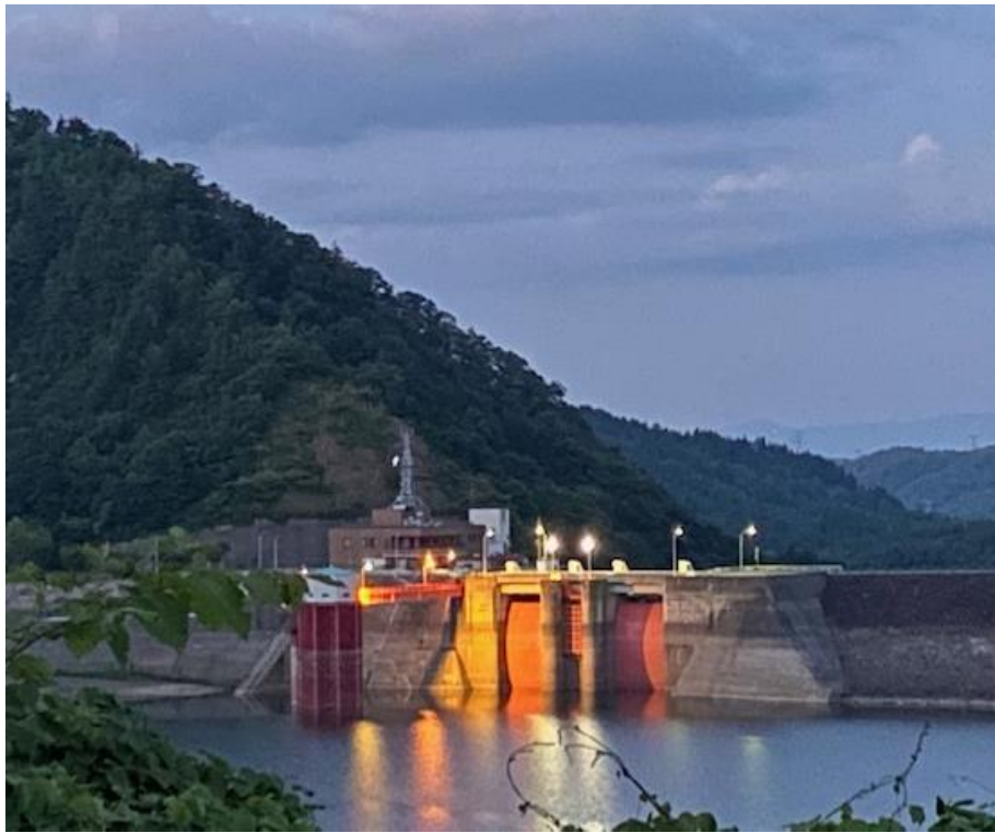
白川ダム・洪水吐のライトアップ
