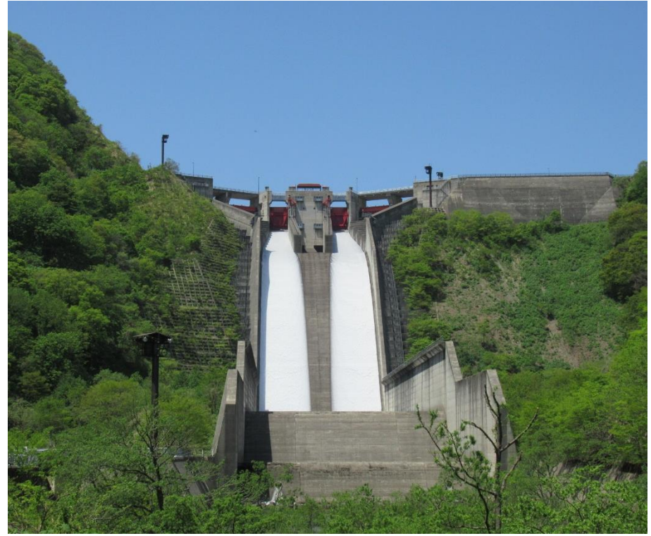
寒河江ダム・クレストラジアルゲート試験放流
