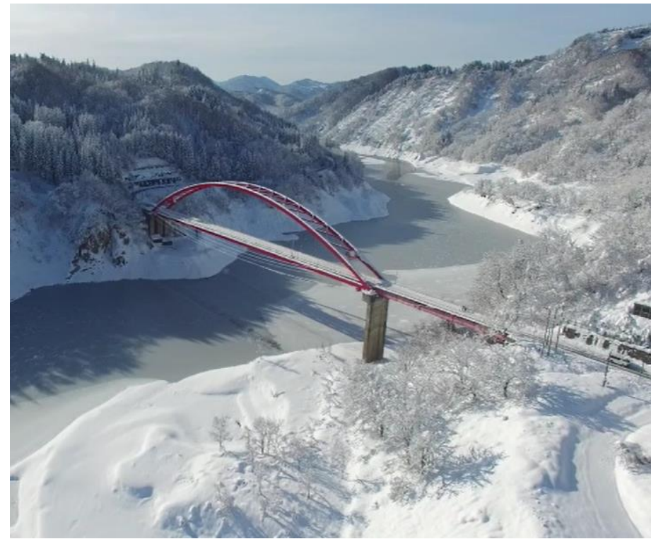
白川ダム・雪の中津川橋
