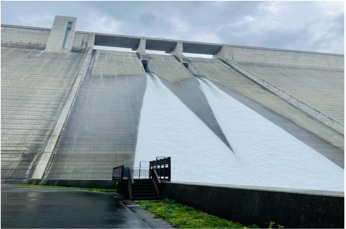
長井ダム 洪水吐の越流
