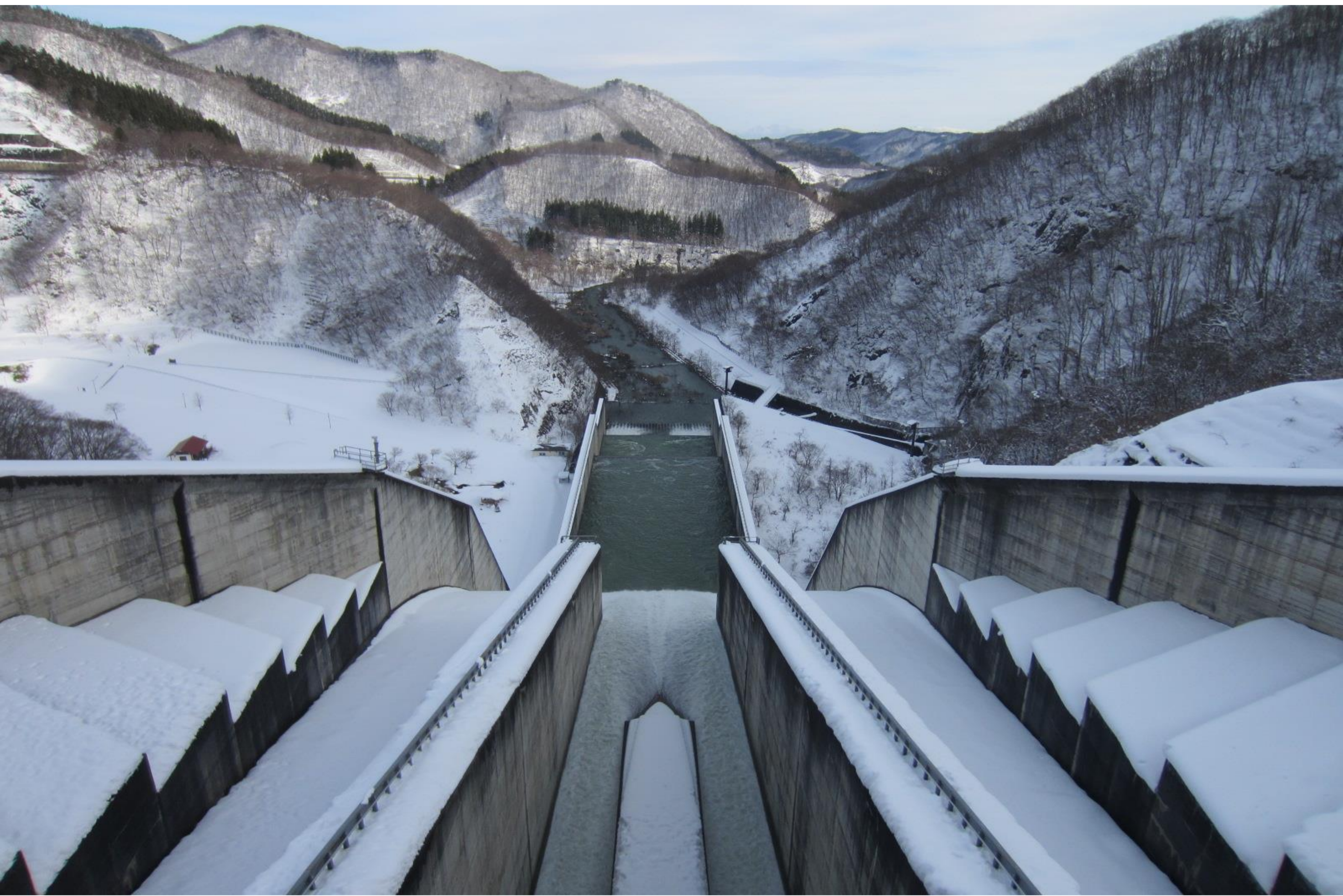
寒河江ダム 洪水吐
