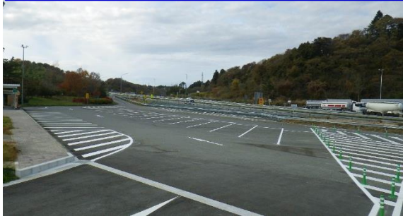
矢本パーキングエリア トイレ側 駐車場
