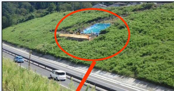
R1年10月12日早朝から雨が降り出し、13日午前1時時点で累計雨量316.5mm最大時間雨量55.5mmを記録した雨により、法面内の水位上昇が原因で法面が不安定化するとともに、表面を流れる水による浸食の拡大が原因で法面が崩壊しました。
