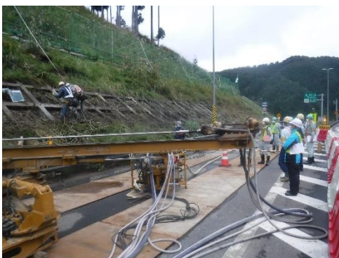
▲現場において安全管理が万全か点検
