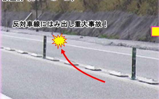
設置前（ラバーポール）
