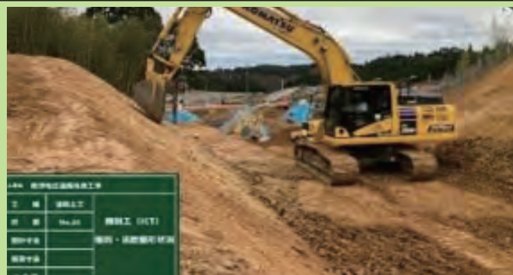
▲ICT建機による施工の効率化・省力化
