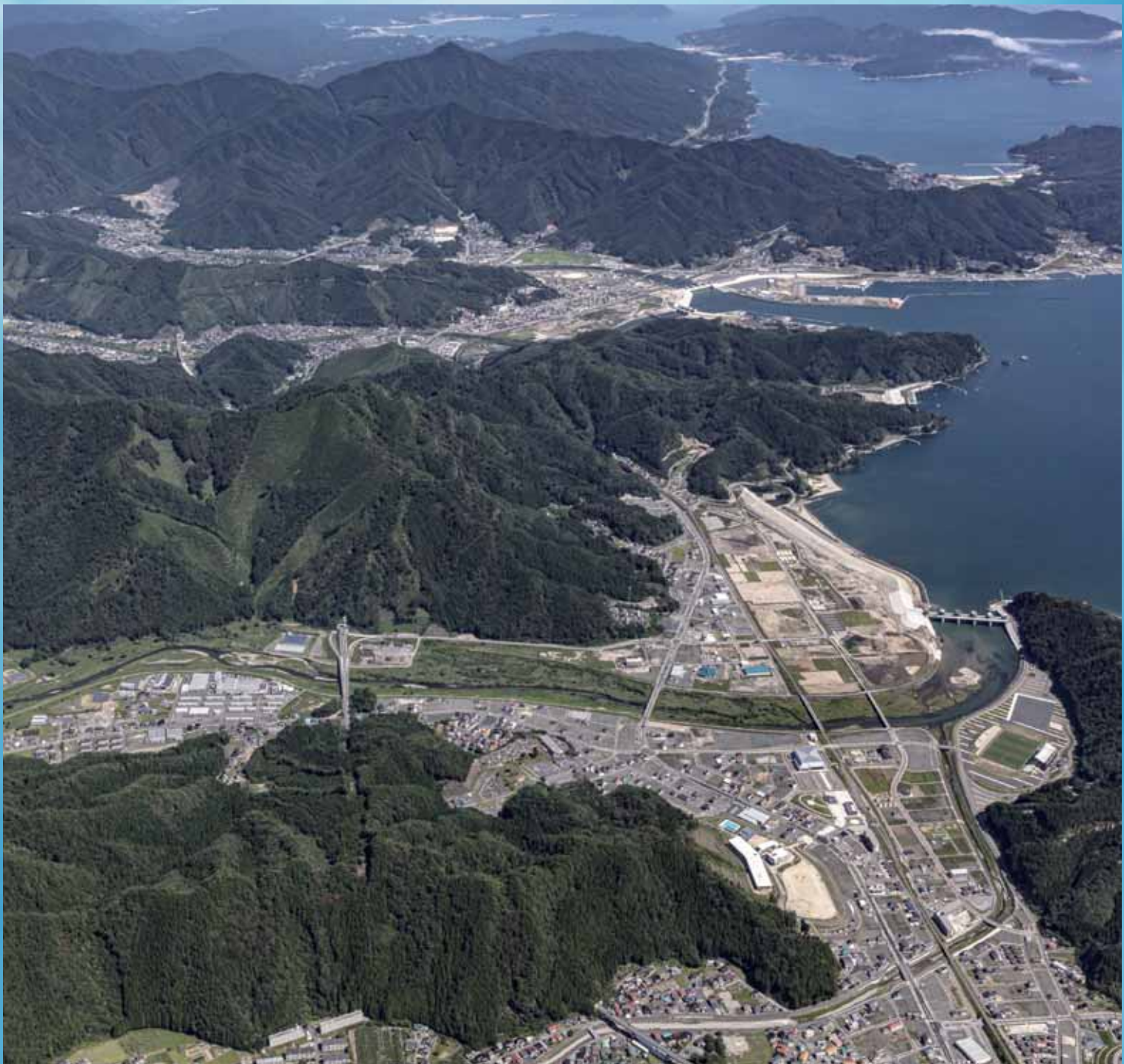
三陸沿岸道路 釜石北 IC 付近から大槌 IC 付近を望む
