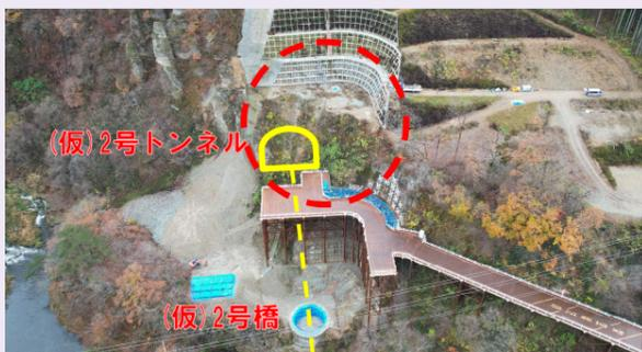
● (仮) 2号橋の橋脚基礎工（大口径深礎杭）は概ね完成しました。引き続き、トンネル坑口周辺の法面工事（赤丸部分）を進めています。
