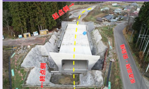
● 本線が通る函渠工の最終ブロックのコンクリート打設が完了しました。今後は、前後の擁壁工事などを進めます。
