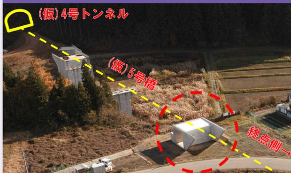
● (仮) 5号橋の終点側の橋台が概ね完成しました。上部工の工事也开始しており、工場での製作後に現場での架設工事を進めます。
