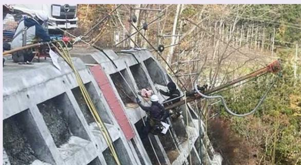
● 法面工事（鉄筋挿入工）の様子。急傾斜地で重機が進んでくれないため、削孔機械も作業者も上方からぶら下って施工しています。
