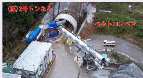
● (仮) 2号トンネル終点側の様子。掘削土排出のためのベルトコンベアを設置して工事を進めています。
