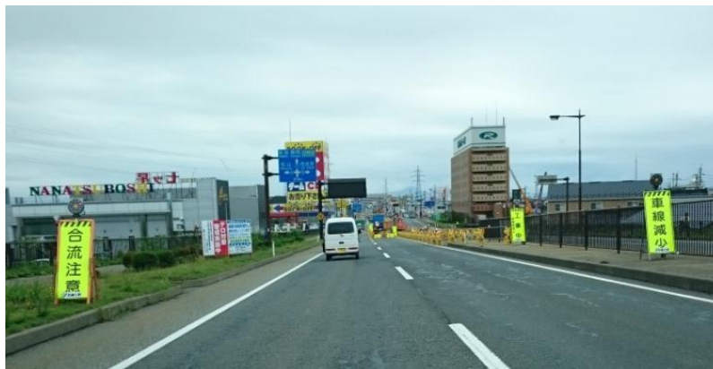
■ 蛍光色の表示板の設置状況
