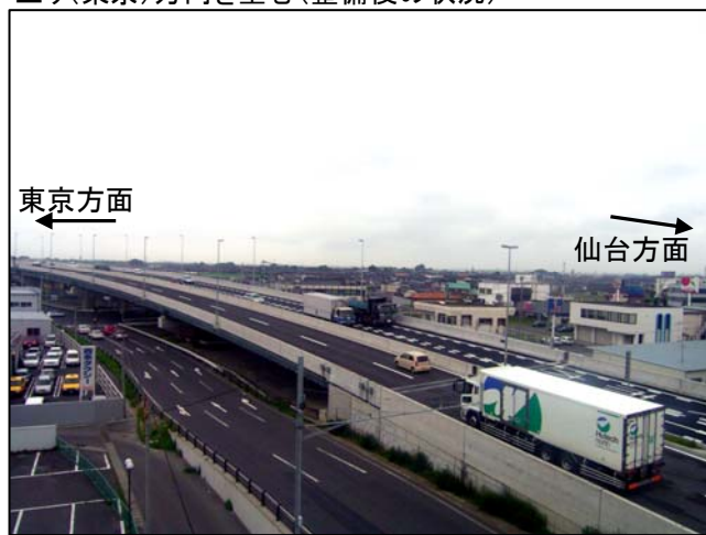
上り(東京)方向を望む(整備後の状況)
