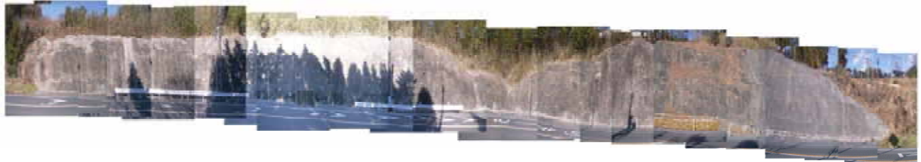
▲北好間地区の法面全景
