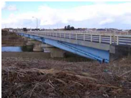
▲真野川橋の全景
