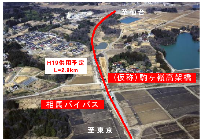
▲駒ヶ嶺高架橋から現6号方向を望む
