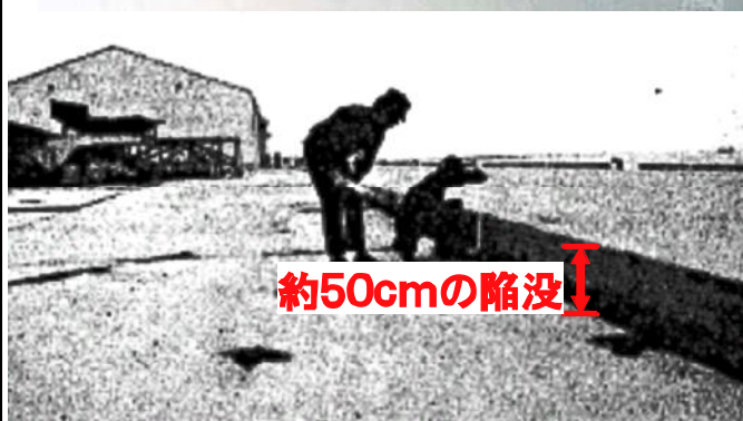
▲地震によって陥没した野積場 (相馬港 昭和53年 宮城県沖地震)
