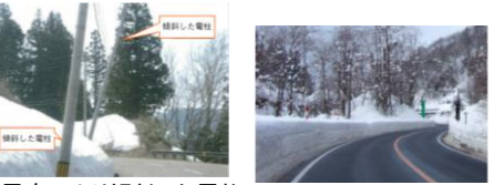
▲雪害により傾斜した電柱(新潟県) 出典：NIT技術ジャーナル
