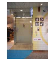
多機能トイレの設置
