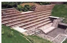
間伐材を用いた治山工事例 (出典：東北森林管理局HP)
