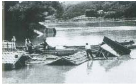
カスリン台風による被害(岩手県川崎村)
