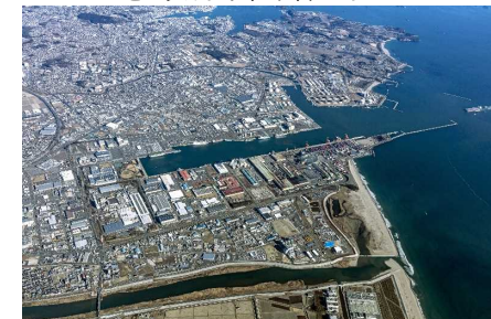
出典：国土交通省 東北地方整備局 仙台塩釜港（仙台港区）
