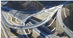
復興道路・復興支援道路の全線開通 (三陸沿岸道 釜石ICの様子)
