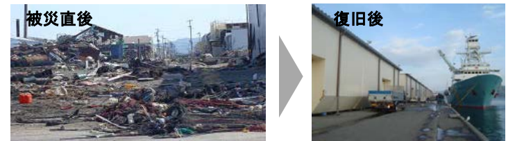
▲被災・沈下した水産施設の復旧(石巻市)
