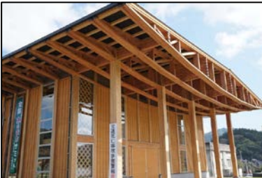
地元の木材を利用した住田町役場新庁舎 出典:東北森林管理局
