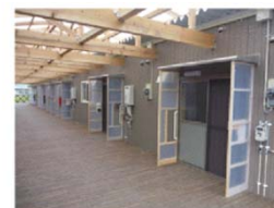
(右) ケアゾーンの仮設住宅
