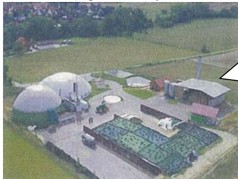
バイオガスプラント
