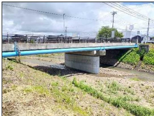
橋脚補強工：完成後(出典：新潟県提供)
