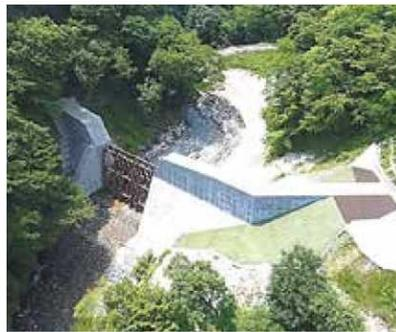
普段は水と土砂は同じように上流から下流に流下する「透過型砂防堰堤」
