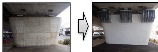
橋梁耐震補強(出典:青森県提供)
