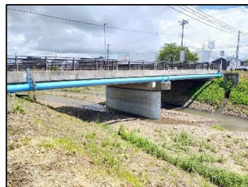
橋脚補強工:完成後(出典:新潟県提供)
