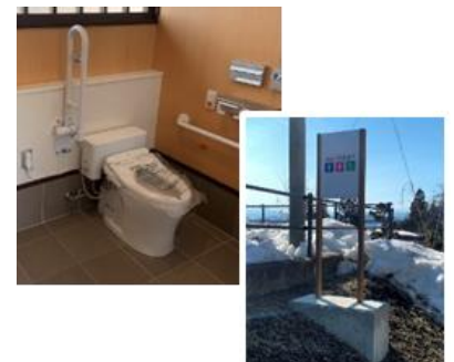
観光地の公衆トイレの洋式化や ピクトサインを整備 (出典:東北運輸局提供)
