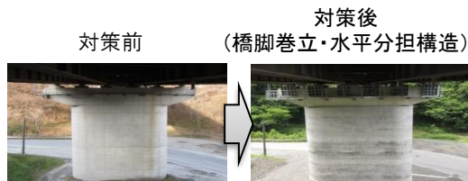
国道284号猿岩橋 橋梁耐震補強(出典:宮城県提供)
