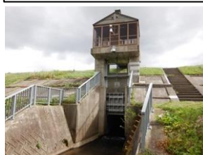
樋門樋管ゲートの無動力化(フラップゲート化)による省人化
