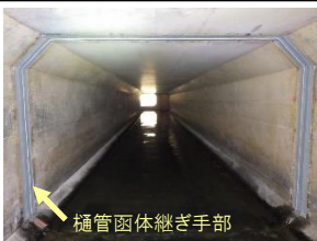
樋管管体継ぎ手部補修
