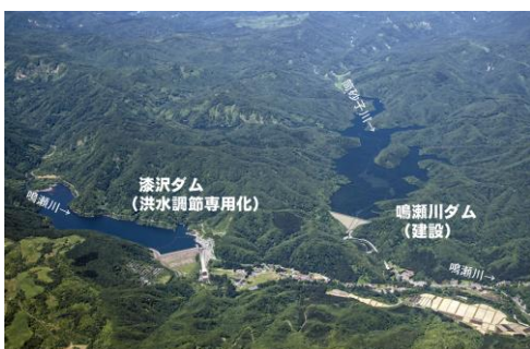
▲鳴瀬川総合開発の完成イメージバース(宮城県・加美町)
