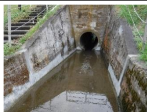
樋管管体断面補修
