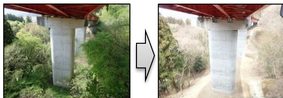
橋梁耐震補強(出典:宮城県提供)
