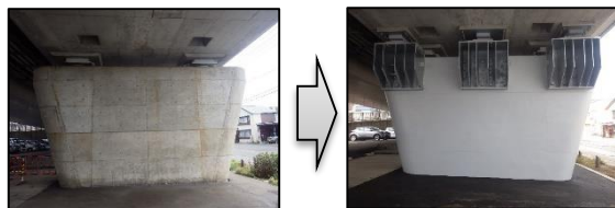
橋梁耐震補強(出典:青森県提供)
