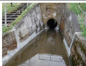
樋管管壁断面補修
