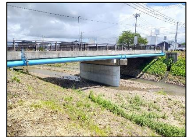
橋脚補強工:完成後(出典:新潟県提供)
