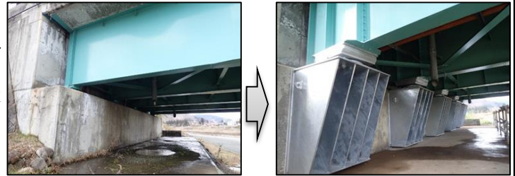
橋梁耐震補強(出典:山形県提供)
