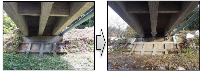
橋梁耐震補強(出典:福島県提供)
