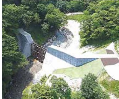
普段は水と土砂は同じように上流から下流に流下する「透過型砂防堰堤」 (代表例)阿武隈川水系須川流域不動沢第4砂防堰堤
