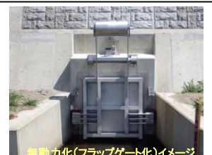
樋門樋管ゲートの無動力化(フラップゲート化)による省人化
