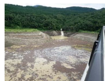
■胆沢ダム流入河川流木
