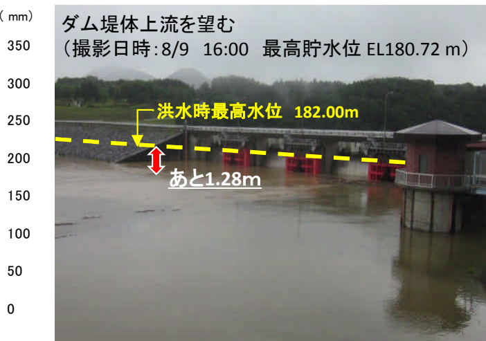
御所ダムの状況
