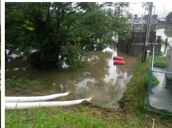
紫波町 高水寺地区堤内地湛水状況
