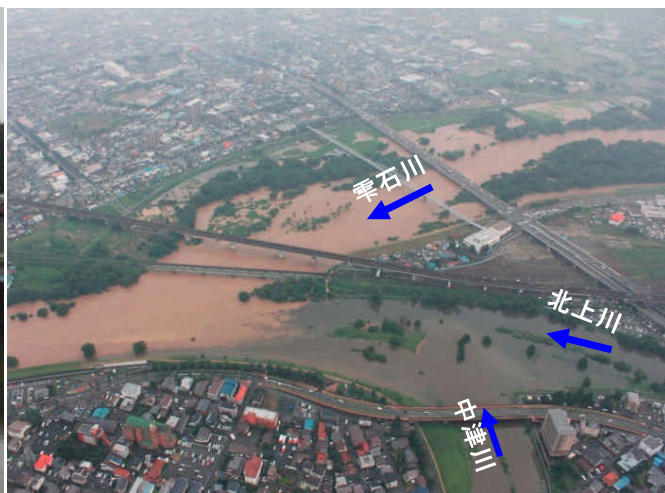
雫石川の合流部付近の状況
