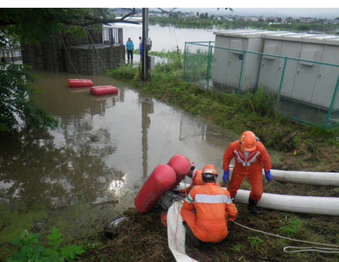
紫波町 高水寺地区ポンプ設置状況
