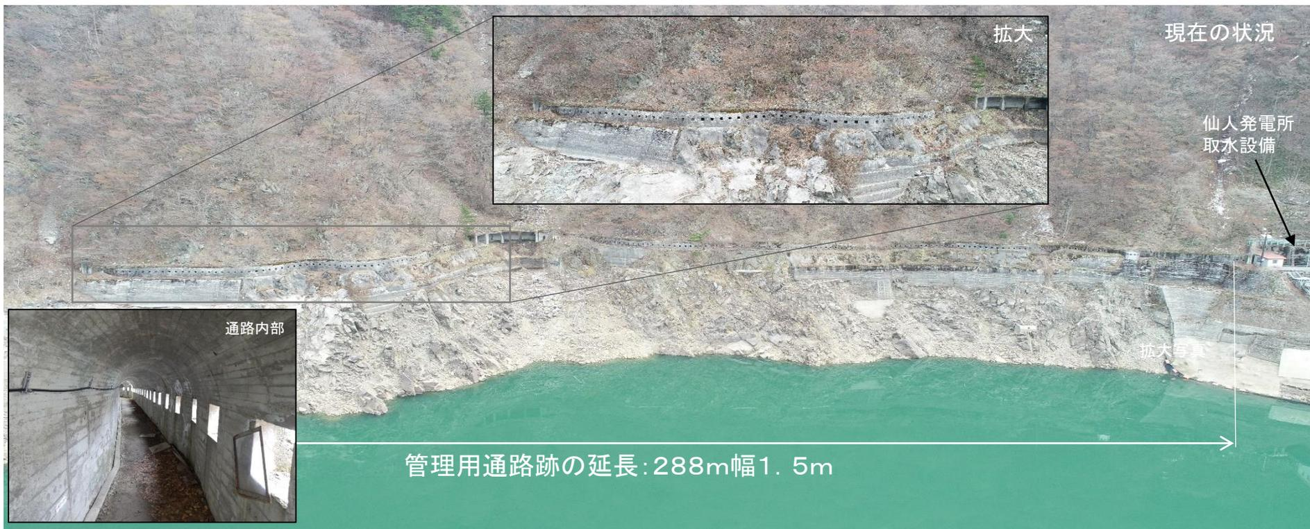
湯田ダムと仙人発電所共同取水口を結ぶ管理用通路は、ダム右岸側に沿って作られました。昭和40年頃の地震によって落石による崩落等の被災がありました。平成20年9月に完成した仙人・和賀川発電所取水口トンネルができるまで使われていたそうです。
