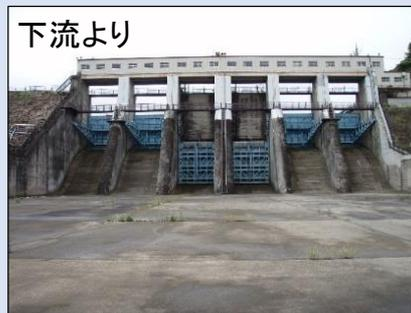
石淵ダムの放流設備は、オリフィスゲート 2門（ローラーゲート 1門あたり高さ7.0m、幅6.8m）、クレストゲート 4門（ラジアルゲート 1門あたり高さ3.9m、幅7.2m）あり、洪水時にはダム下流への被害を最小限に抑えるように洪水調節を行いました。
