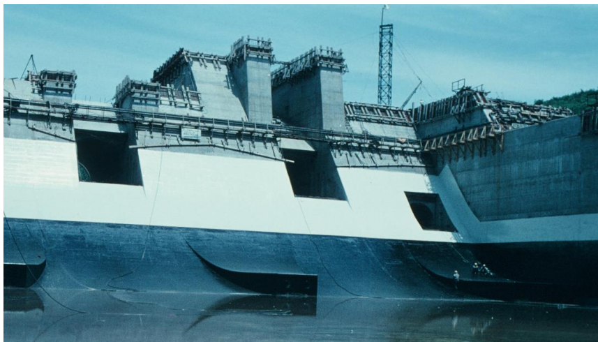
耐酸塗料塗布状況
