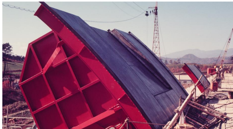
クレストゲート施工状況
