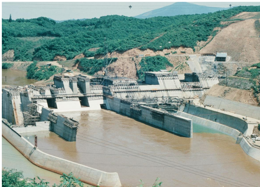
ダム湛水前(建設中)の状況
