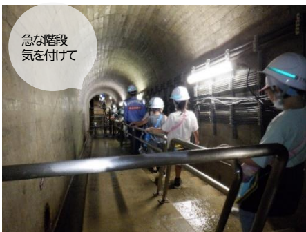
監査廊(ダムの中)です
