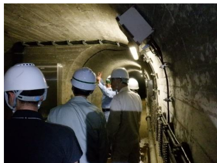
監査廊（ダムの中）
