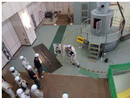
四十四田発電所の内部
