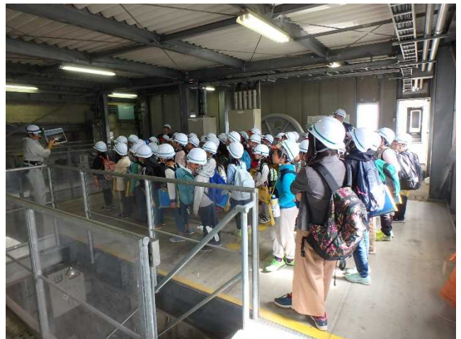
ゲート操作室を見学
