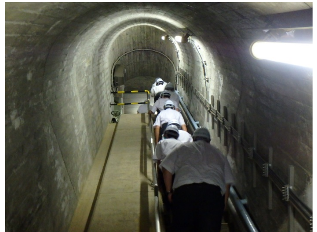
監査廊の斜度45°の階段
