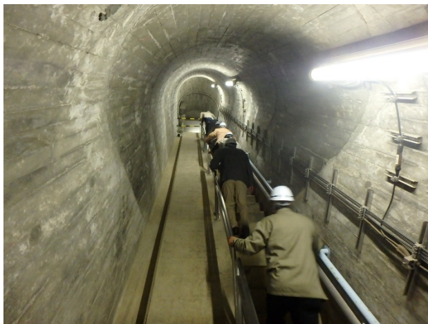
監査廊内の急な階段
