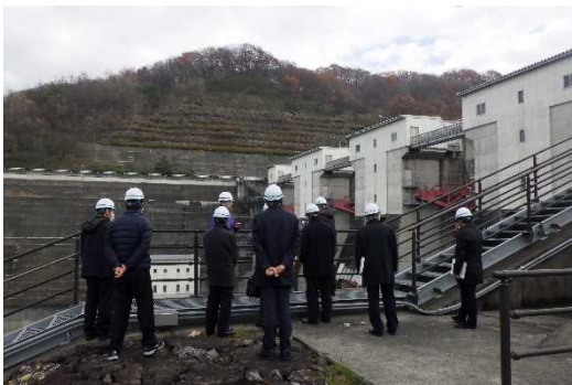
御所発電所や放流中のダムに ついての説明
