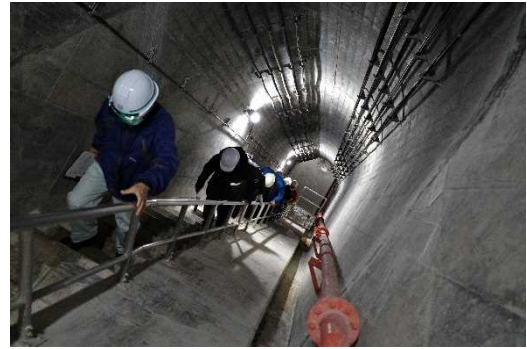
監査廊内は急な階段が続きます
