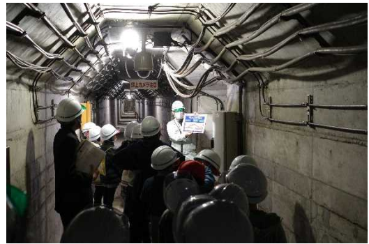
監査廊の見学
