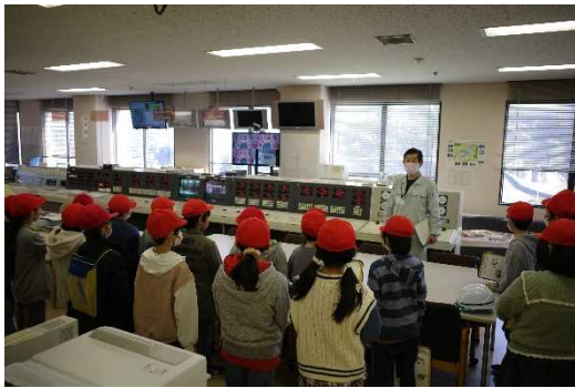
操作室では実際のダム操作の様子を見学
