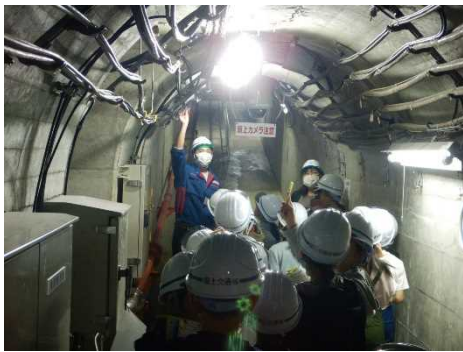
監査廊の見学
