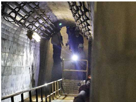
監査廊の見学
