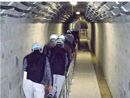
最深部から階段をゆっくり上がります。途中、漏水観測について説明。
