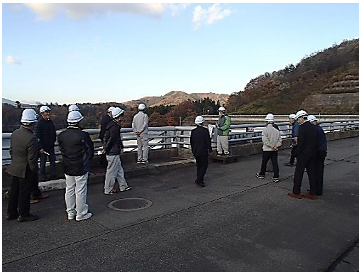
天端から放流ゲートや下流にある御所発電所について説明。
