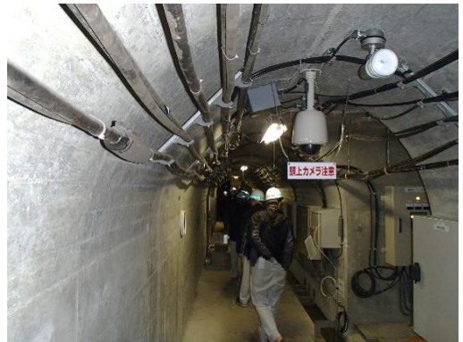
放流ゲート側から監査廊へ入り、最深部まで階段で下がります。最深部では地震計など説明。
