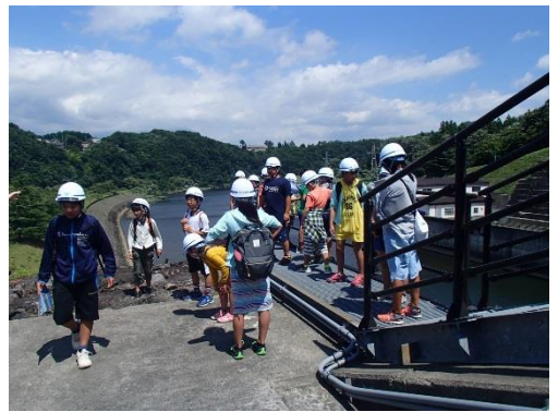
階段を上がると放流ゲートが間近に。 放流ゲートと御所発電所について説明。
