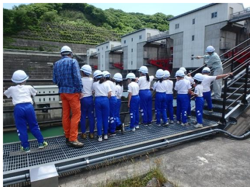
間近に見るダムの放流ゲート
