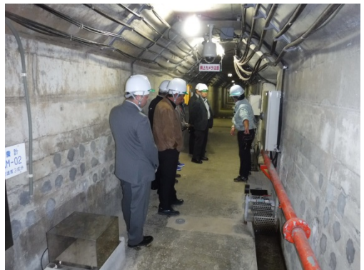
監査廊にて漏水観測について説明
